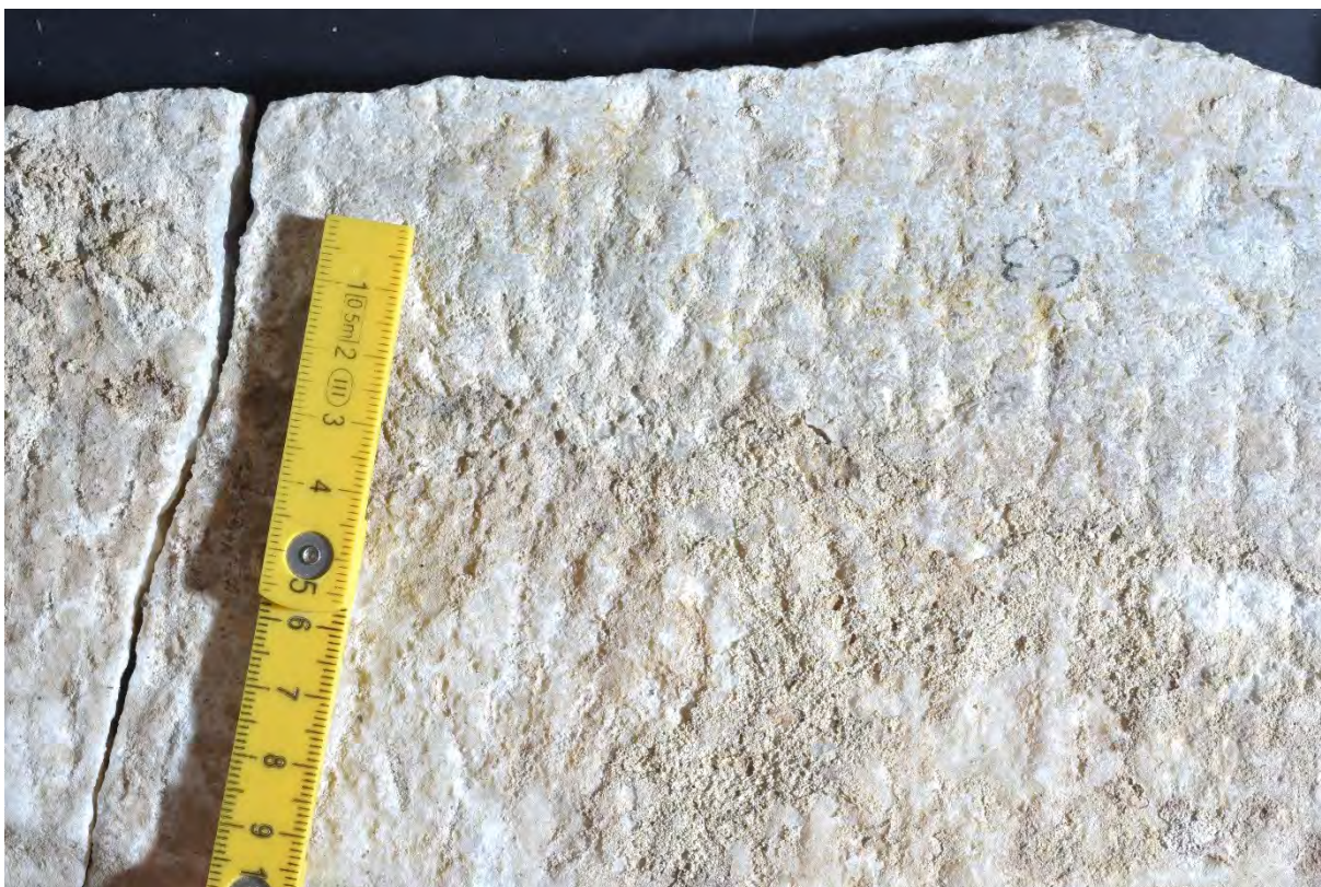
Fot. 17 Ślady obróki kamieniarskiej – powierzchnia obrobiona wstępnie dłutem szpic a następnie wygładzona materiałem ściernym
