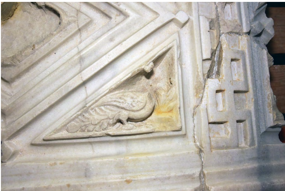
Fot. 9 Fragment dekoracji balustrady balkonu ambony po czyszczeniu preparatem Clean Galena
