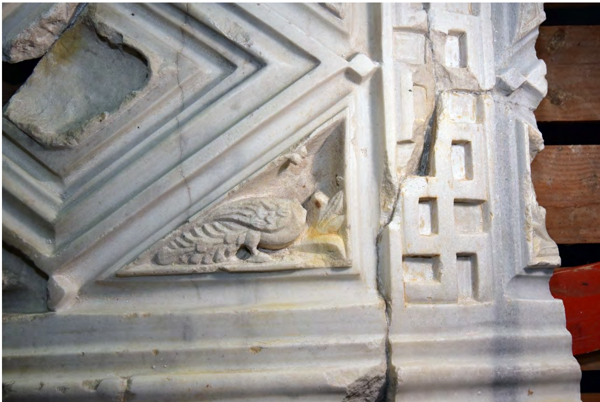
Fot. 8 Fragment dekoracji balustrady balkonu ambony przed czyszczenie preparatem Clean Galena
