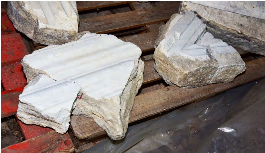
Fot. 4 Fragmenty balustrady ambony po sklejeniu
