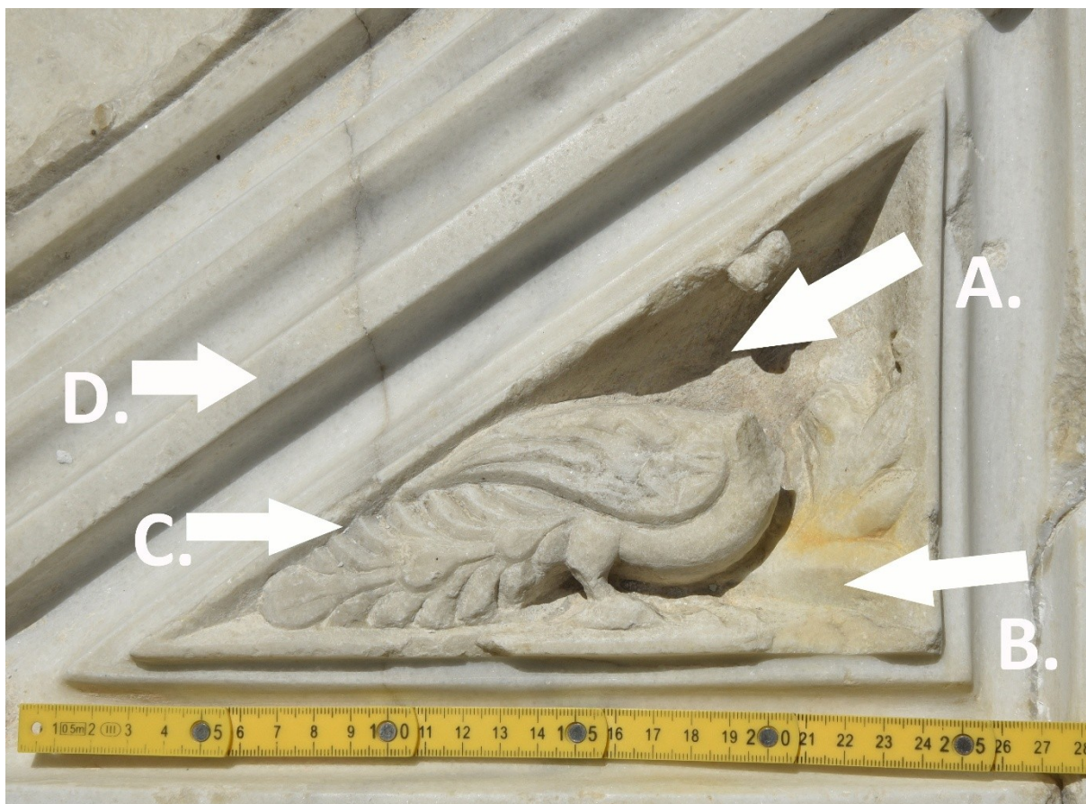
Fot. 31 Fragment dekoracji rzeźbiarskiej centralnej części balustrady balkonu ambony. A. ślady obróbki powierzchni kamienia tarnikiem, B. dłutem płaskim o szer. grotu 12 mm, C. dłutem płaskim o szer. grotu 5 mm, D. powierzchnia profilowań wygładzona materiałami ściernymi (np. piaskowiec, pumeks)
