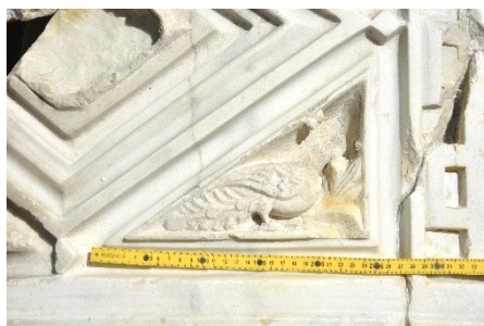
Fot. 7 Fragment rzeźbionej balustrady balkonu ambony ze śladami narzędzi kamieniarskich
