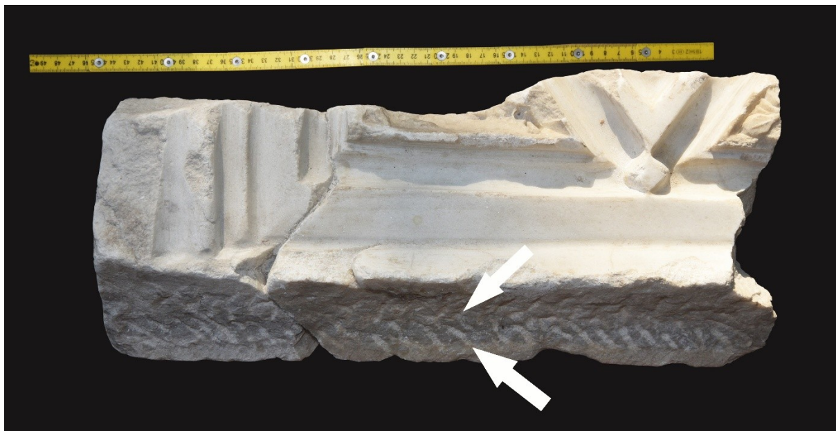
Fot. 30 Fragment balustrady balkonu ambony. Ślady użycia dłuta płaskiego o szer. grotu 5mm. Powierzchnia styku elementów składowych balustrady
