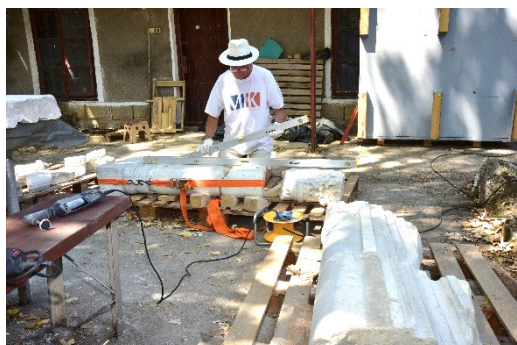
Fot. 1. Konserwacja wybranych elementów marmurowej ambony. Sierpień 2025
