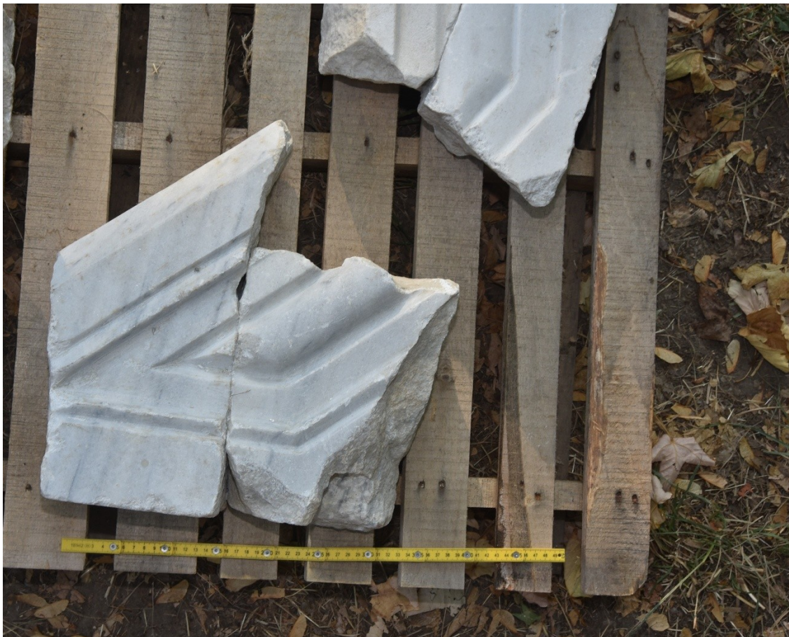
Fot. 16 Oczyszczone i sklezione fragmenty balustrady schodów ambony
