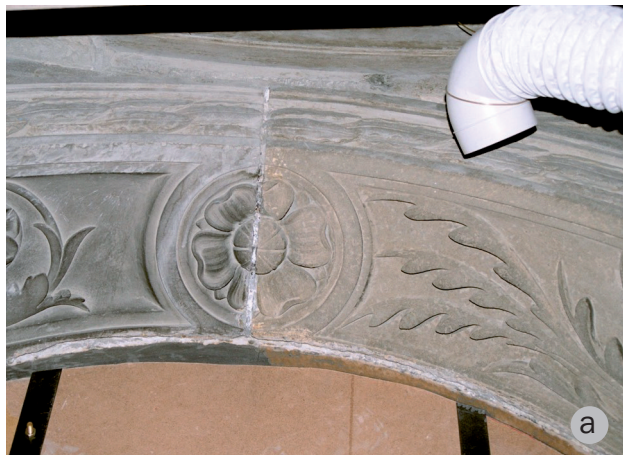
Rys.3.9.6. Pył i odpady powstające podczas czyszczenia laserowego usuwane są przez wbudowany system ekstrakcyjny. Kaplica Zygmuntowska na Wawelu. Fot. J. Marczak.
