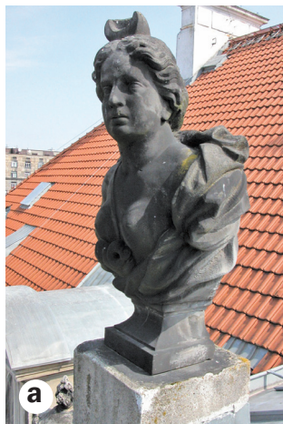
Rys. 1.2.2. a) – Wpływ osadzania się sadzy, kurzu i cząstek zanieczyszczających na wygląd popiersi ozdabiających pałac Czapskich – siedziba Akademii Sztuk Pięknych w Warszawie. b) – Głowa kobiety w trakcie oczyszczania impulsowym promieniowaniem laserowym. Fot. A. Koss.
