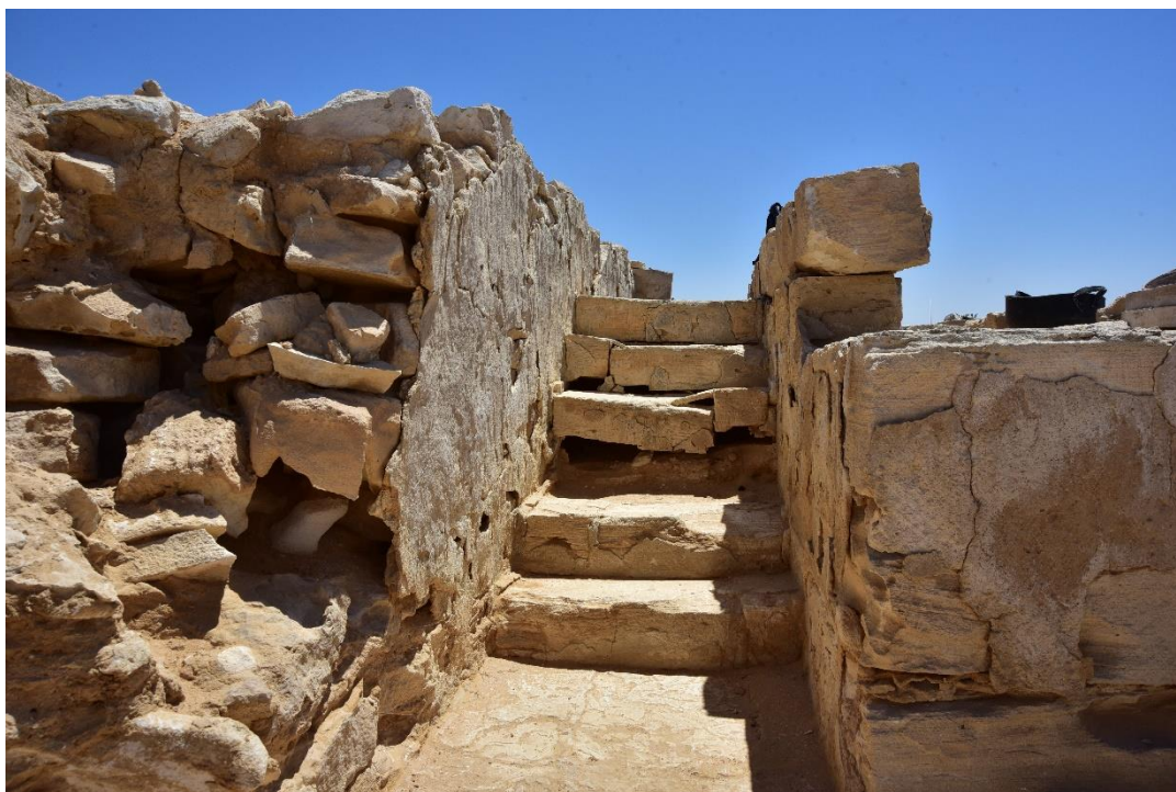
Fot. 66 Klatka schodowa domu H1, stan przed konserwacją
