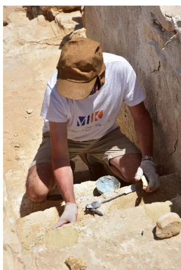
Fot. 6 Prace konserwatorskie przy klatce schodowej domu H1
