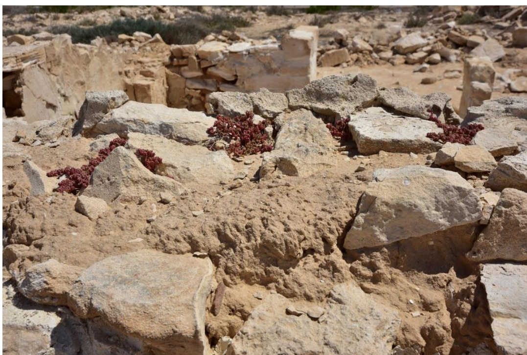
Fot. 51 Roślinność porastająca koronę murów, przyczyniająca się do stopniowej degradacji konstrukcji
