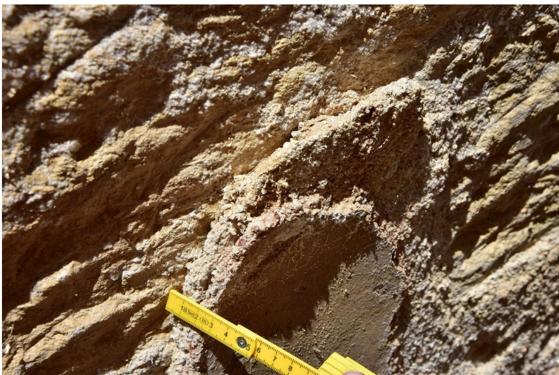
Fot. 71 Tynk hydrauliczny na ścianie cysterny nr 1
