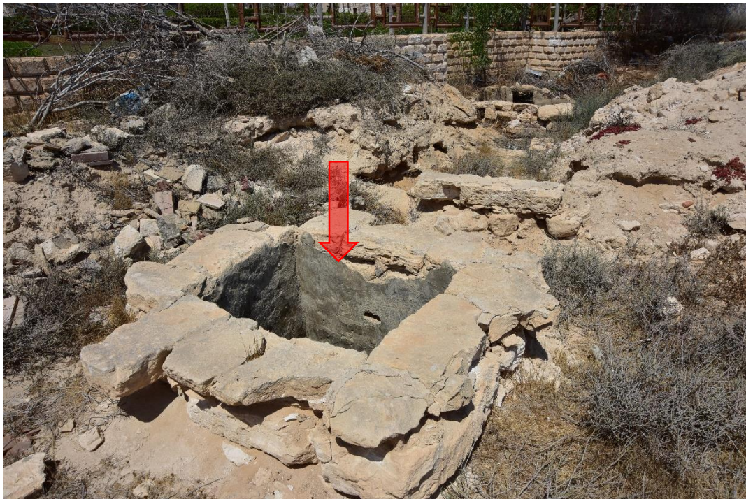
Fot. 35 Studnia cysterny nr 2 z widocznymi tynkami cementowymi
