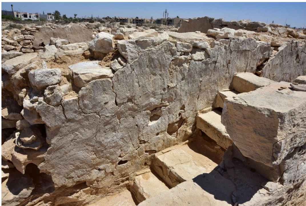
Fot. 54 Klatka schodowa domu H1, ściana północno-wschodnia – stan przed konserwacją
