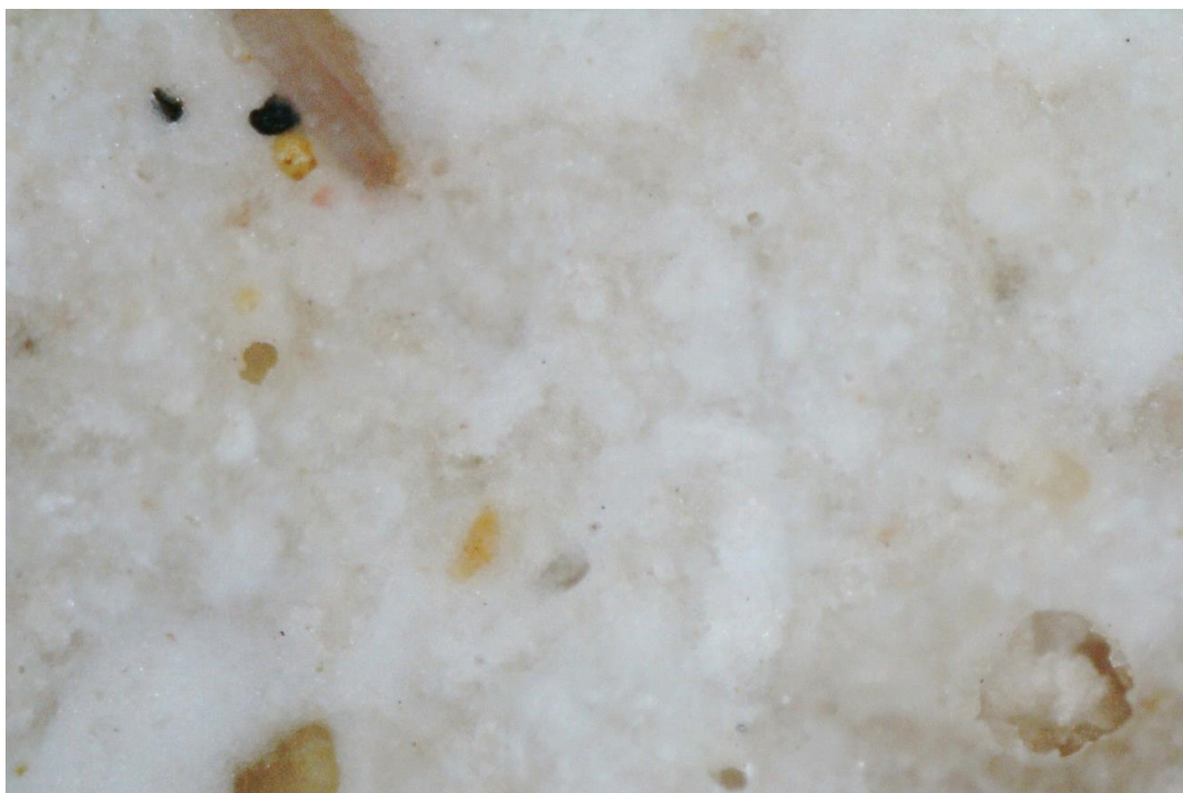
Fot. 25 Fragment zaprawy mocującej stopnie klatki schodowej domu H1 P3 powiększenie x 200.
