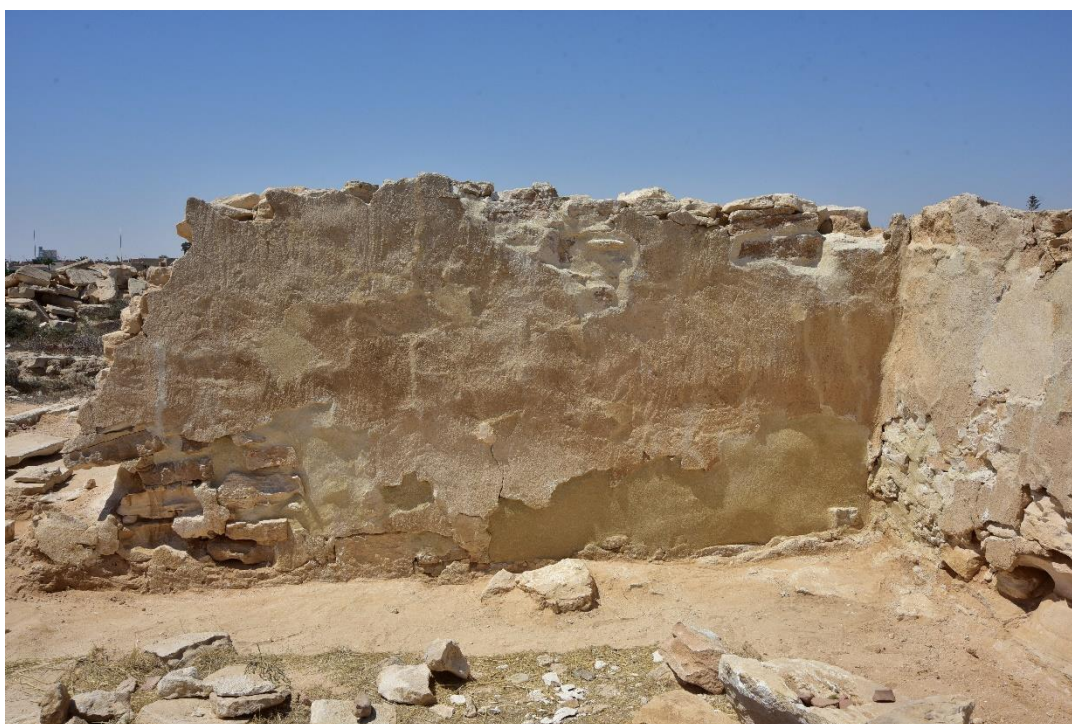
Fot. 61 Dom H1, Oikos. Ściana południowa. Stan po konserwacji
