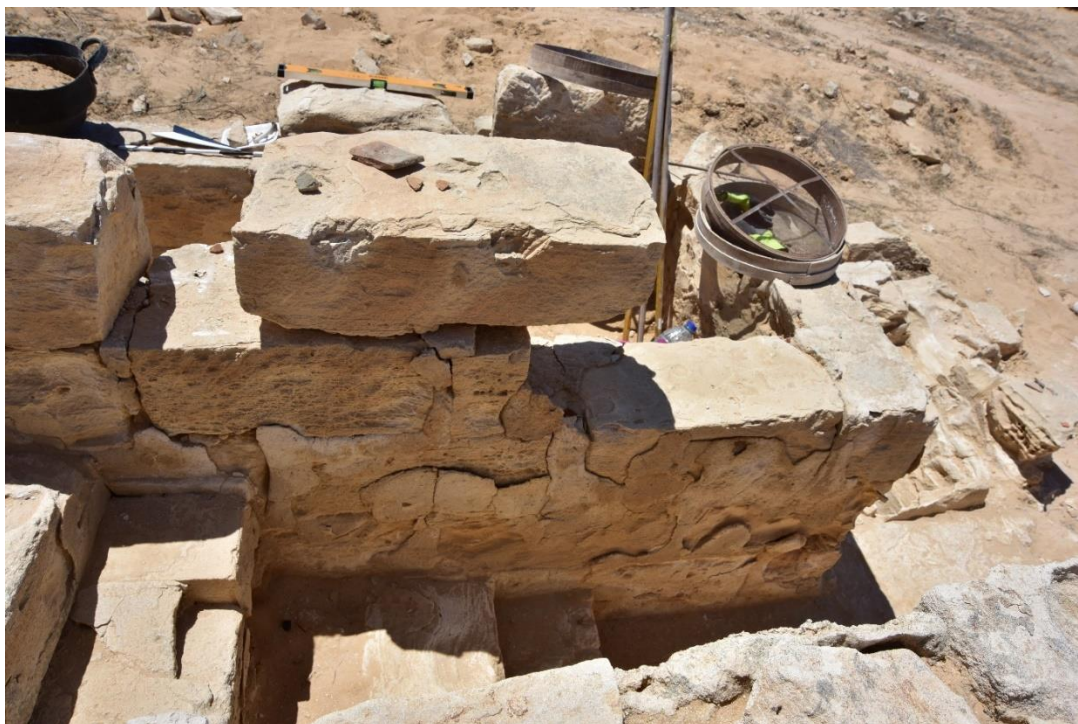
Fot. 58 Klatka schodowa domu H1, ściana północno-zachodnia – stan przed konserwacją
