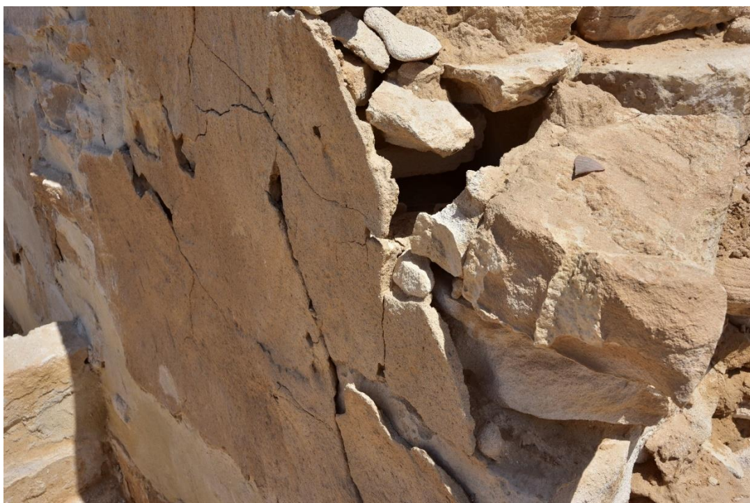
Fot. 50 Stan zachowania tynków przez konserwacją, typowy dla domu H1. Widoczne rozległe ubytki, odspojenia i pęknięcia
