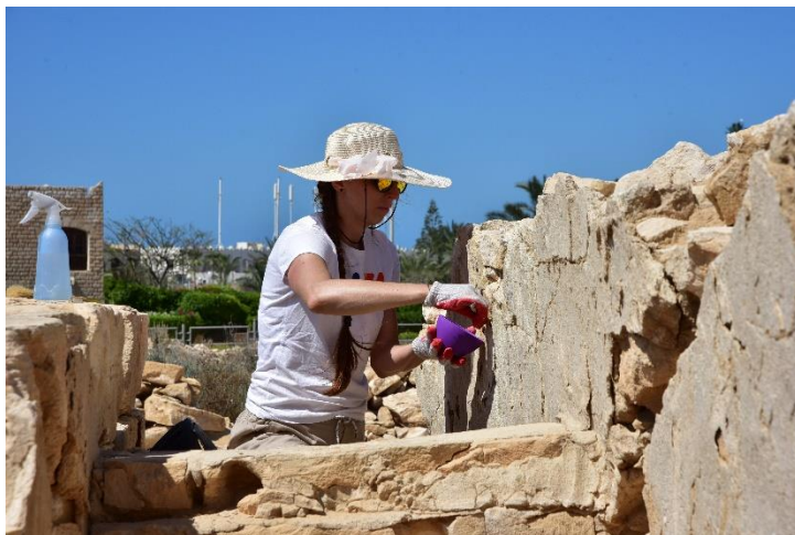
Fot. 5 Zabezpieczanie historycznych tynków opaskami i kitami mineralnymi
