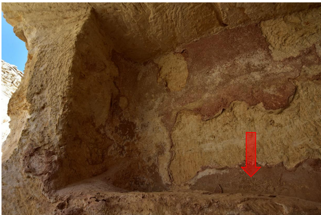
Fot. 32 Antyczna cysterna (nr1) z widocznymi tynkami hydraulicznymi na ścianach
