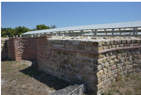
Fot. 7, 8. Mury kamienne po konserwacji w 2014 r. Korony murów spojone zaprawą z wypełniaczem ceramicznym
