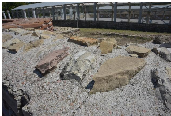
Fot. 7, 8. Mury kamienne po konserwacji w 2014 r. Korony murów spojone zaprawą z wypełniaczem ceramicznym
