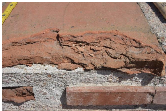
Fot. 5 Widoczny destrukcyjny wpływ zbyt silnej zaprawy murarskiej i spoiny
